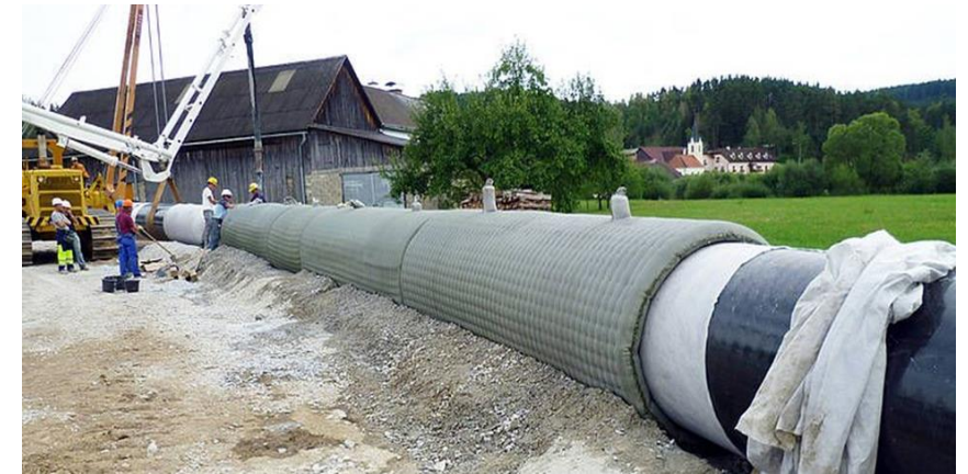
Zabezpieczenie rurociągów i przepustów
