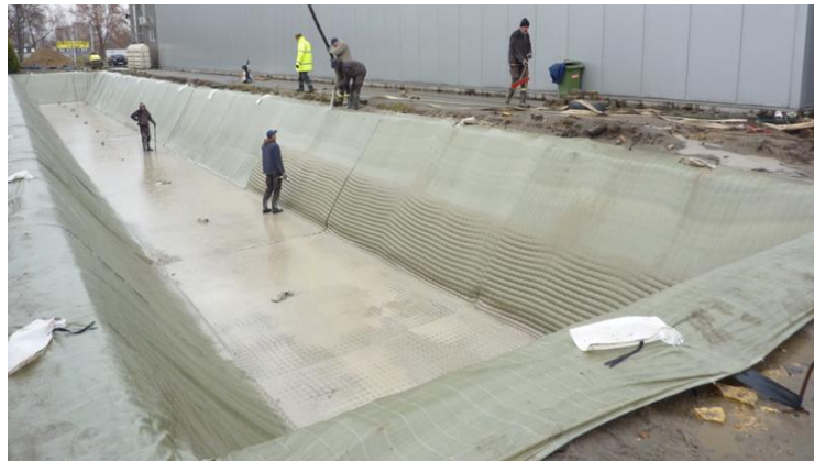
Konstrukcja i ochrona skarp o dużym nachyleniu
