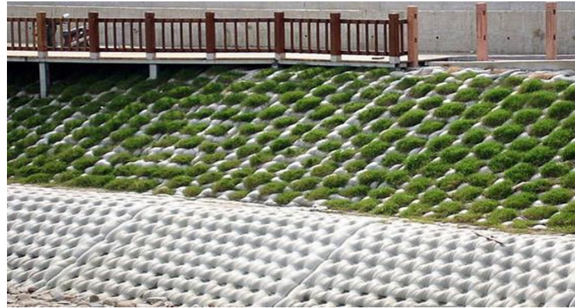
Umacnianie skarp, wałów, kanałów, ochrona przed erozją oraz zazielenianie
