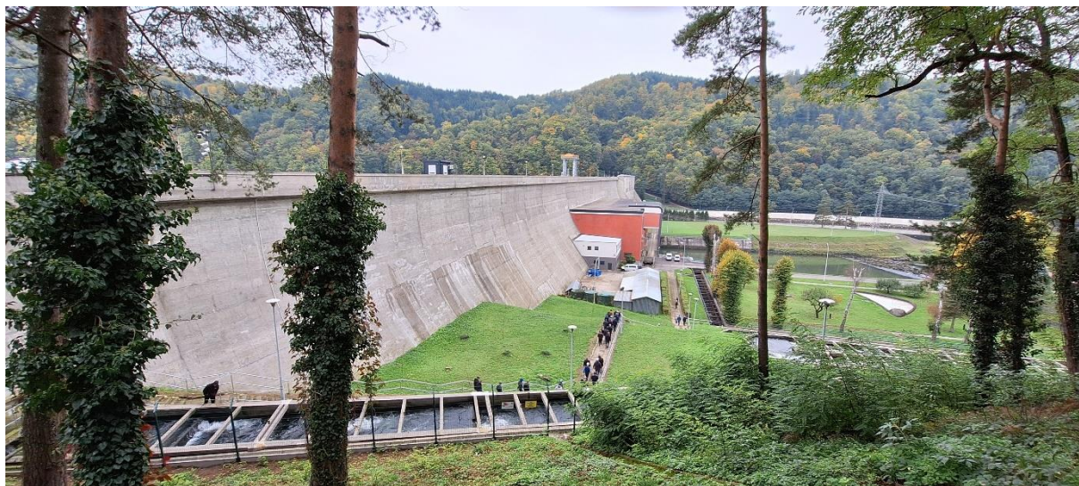
Fot. 9 Uczestnicy wizyty studyjnej schodzą wzdłuż przepławki i zapory w kierunku EW Rożnów. Widok z drogi jezdnej prowadzącej w kierunku zapory
